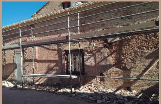
Retirada del revestimiento de cemento de la fachada lateral de El Castell.
